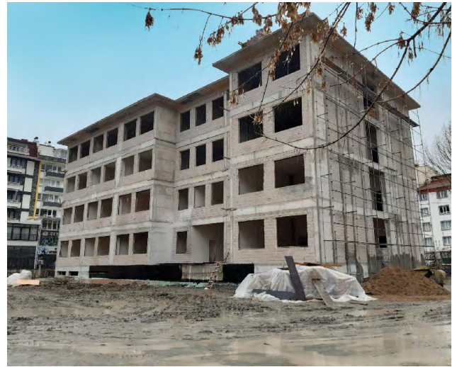
Yapımı devam eden Merkez Fuatpaşa Ortaokulu inşaat çalışması.
