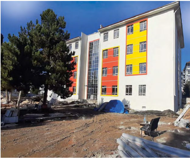
İnşaata büyük ölçüde tamamlan Merkez Ümrân Aygen Ortaokulu.
