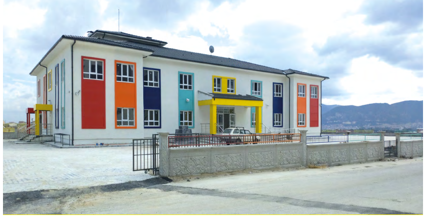
İnşaata büyük ölçüde tamamlan Akkent Anaokulu.
